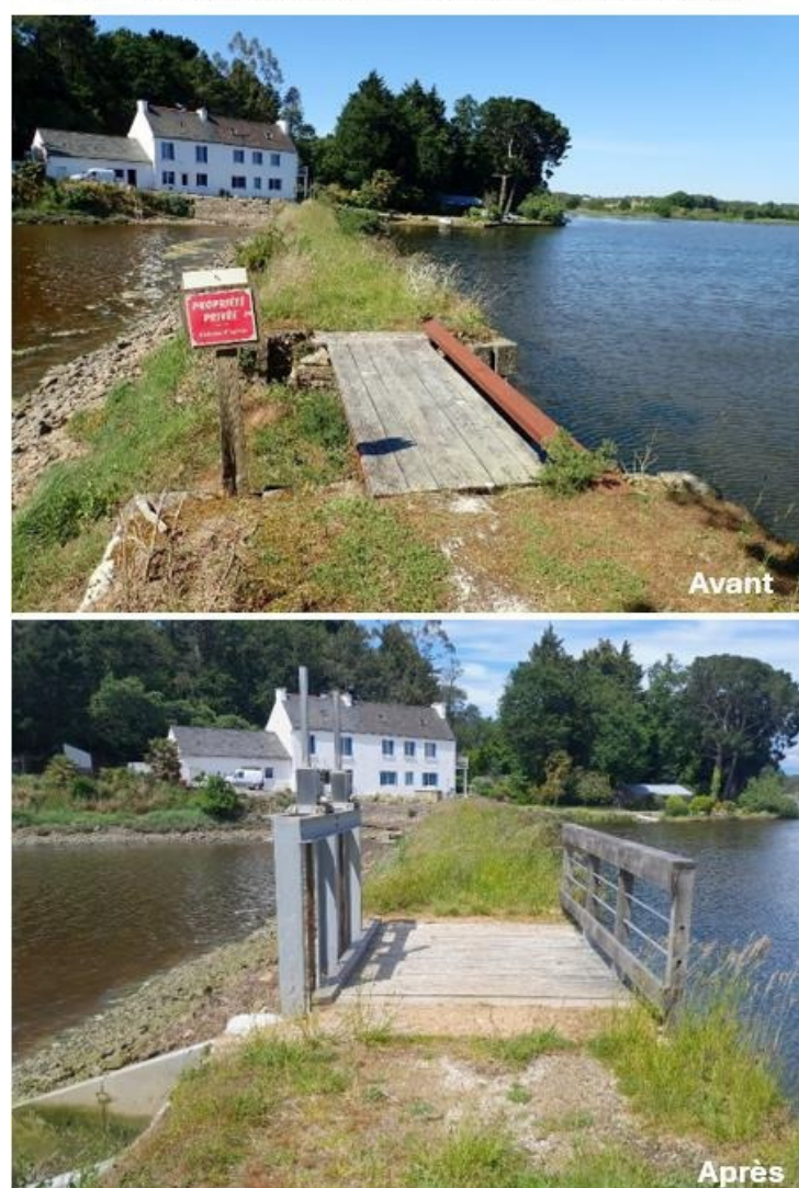
Réfection des ouvrages Installation de nouvelles vannes - remplacement de la passerelle
