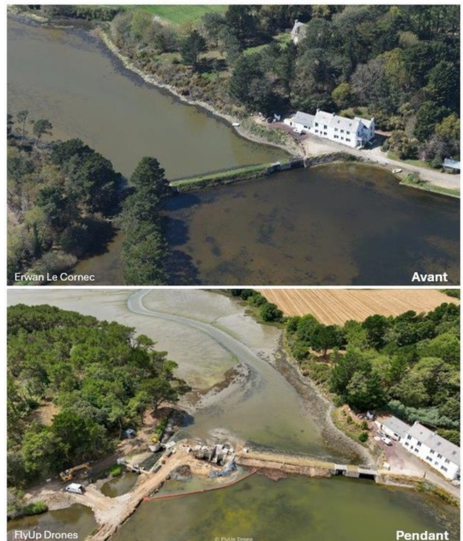
Réfection des ouvrages Installation de nouvelles vannes
