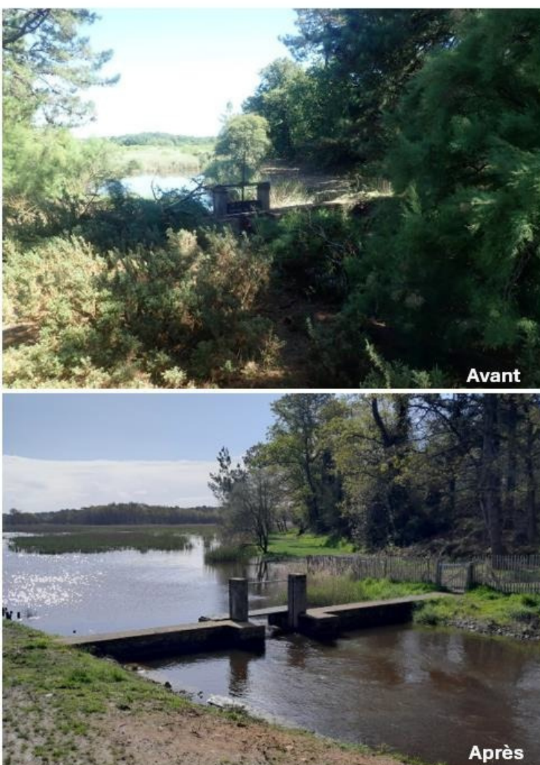
Réfection des ouvrages Gestion de la végétation – suppression d'une vanne en non-conformité avec la continuité écologique
