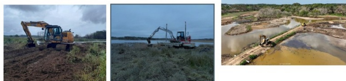
Travaux de terrassement : reprofilage des berges, réfection des digues ; restauration de prairies humides (crédit photo ICEO – drone Fly up drone)
