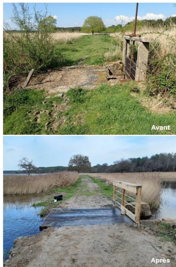
Réfection des ouvrages Remplacement de la passerelle – suppression d'une vanne en non-conformité avec la continuité écologique
