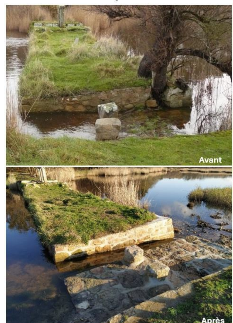
Réfection des ouvrages Installation d'une passe à poissons avec tapis brosse - rejointolement des maçonneries
