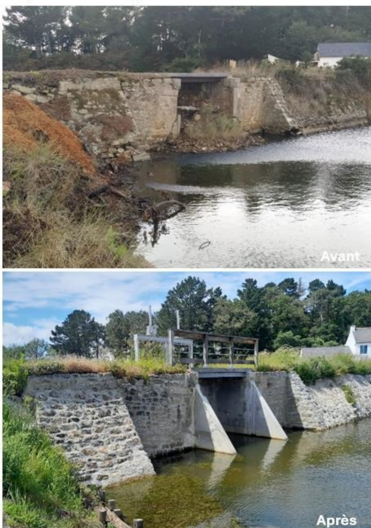
Réfection des ouvrages Rejointolement des maçonneries – installation de nouvelles vannes
