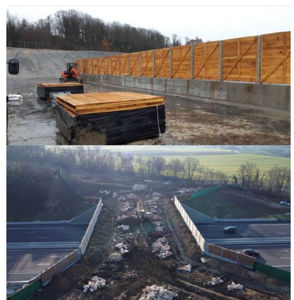
Figure 6 : mise en place des écrans visuels (en haut) et de la terre végétale (en bas)
