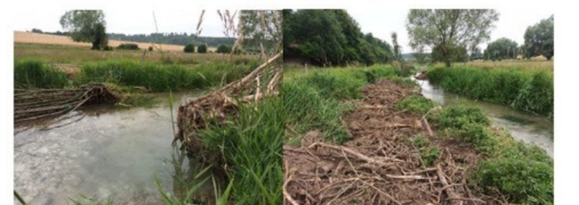
la surlargeur corrigée grâce aux techniques végétales - après travaux.
