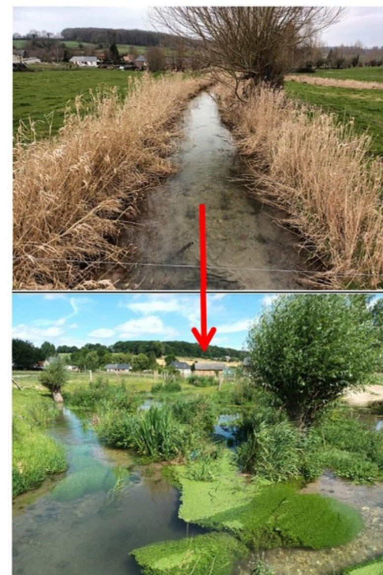
Le long canal transformé en cours d'eau avec des méandres et des zones humides alluviales
