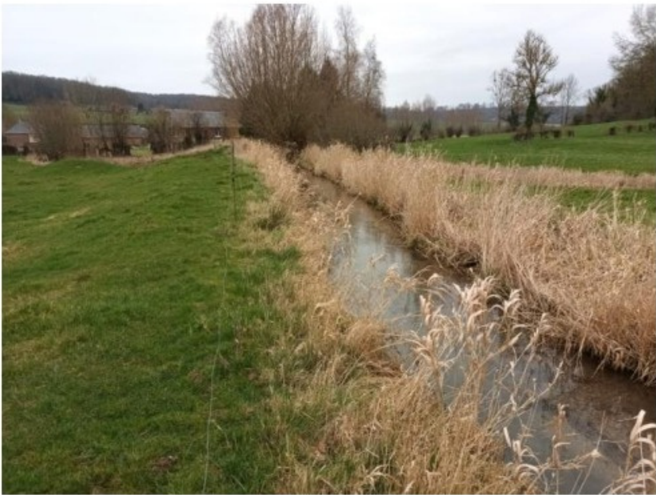
Avant travaux, le ruisseau d'Haudricourt est sur son tiers amont canalisé, envasé et perché
