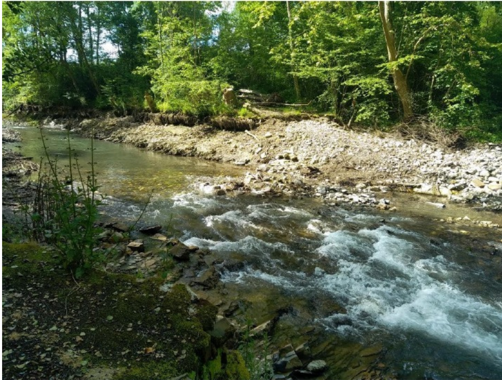
Vue de l'emplacement du barrage après travaux
