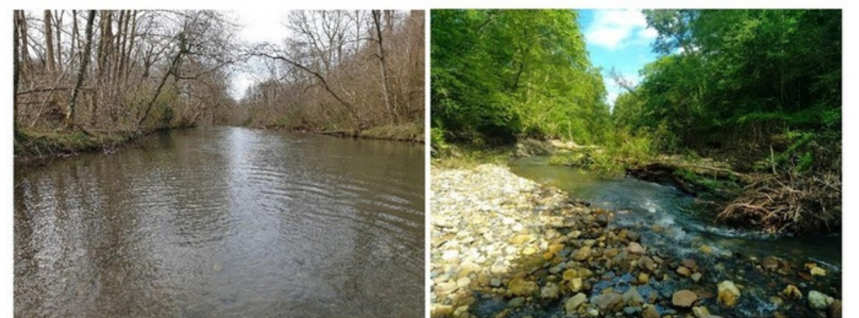
Amont du barrage : avant (à gauche) et après (à droite)
