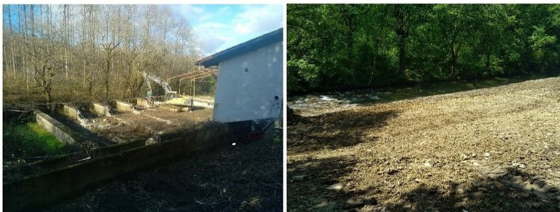
Vue générale des bassins de pisciculture pendant la démolition (à gauche) et terrassement final (à droite)
