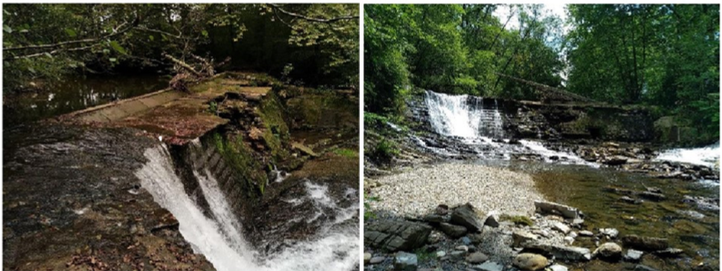
Vues du barrage avant travaux
