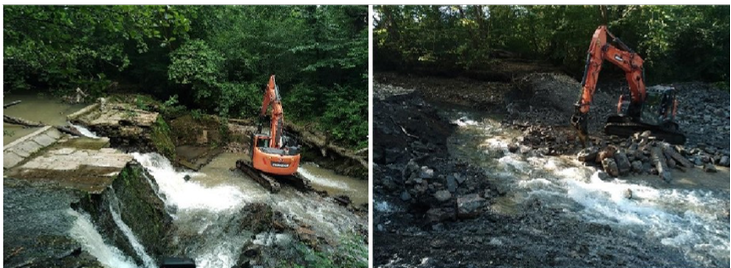
Vues du barrage pendant les travaux
