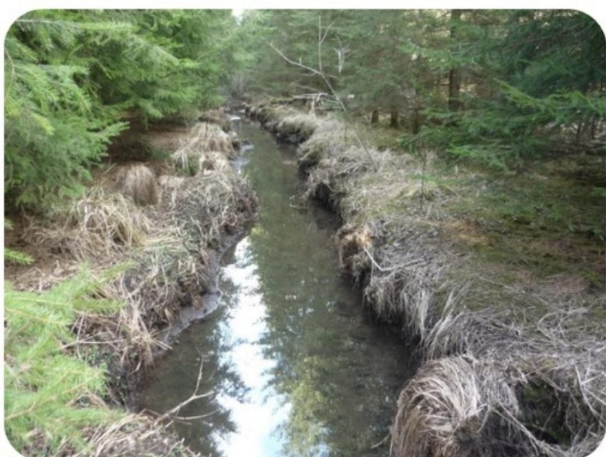
Cours d'eau rectifié avant travaux
