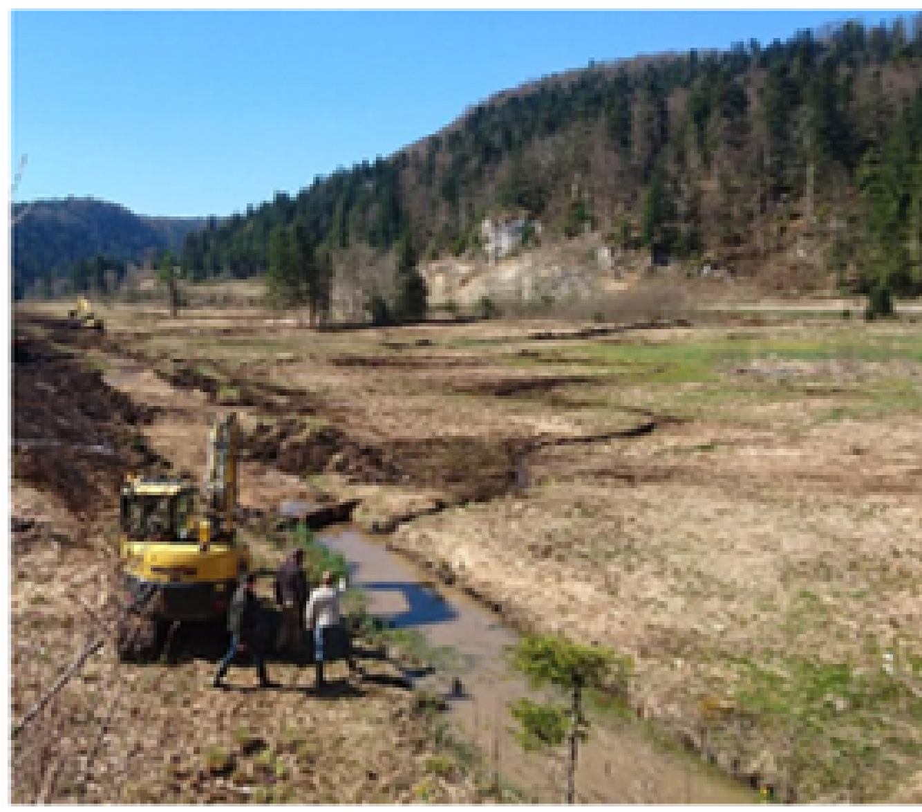
Mise en place d'un bouchon à l'intersection du lit rectifié et du lit guide (source : FDCJ)
