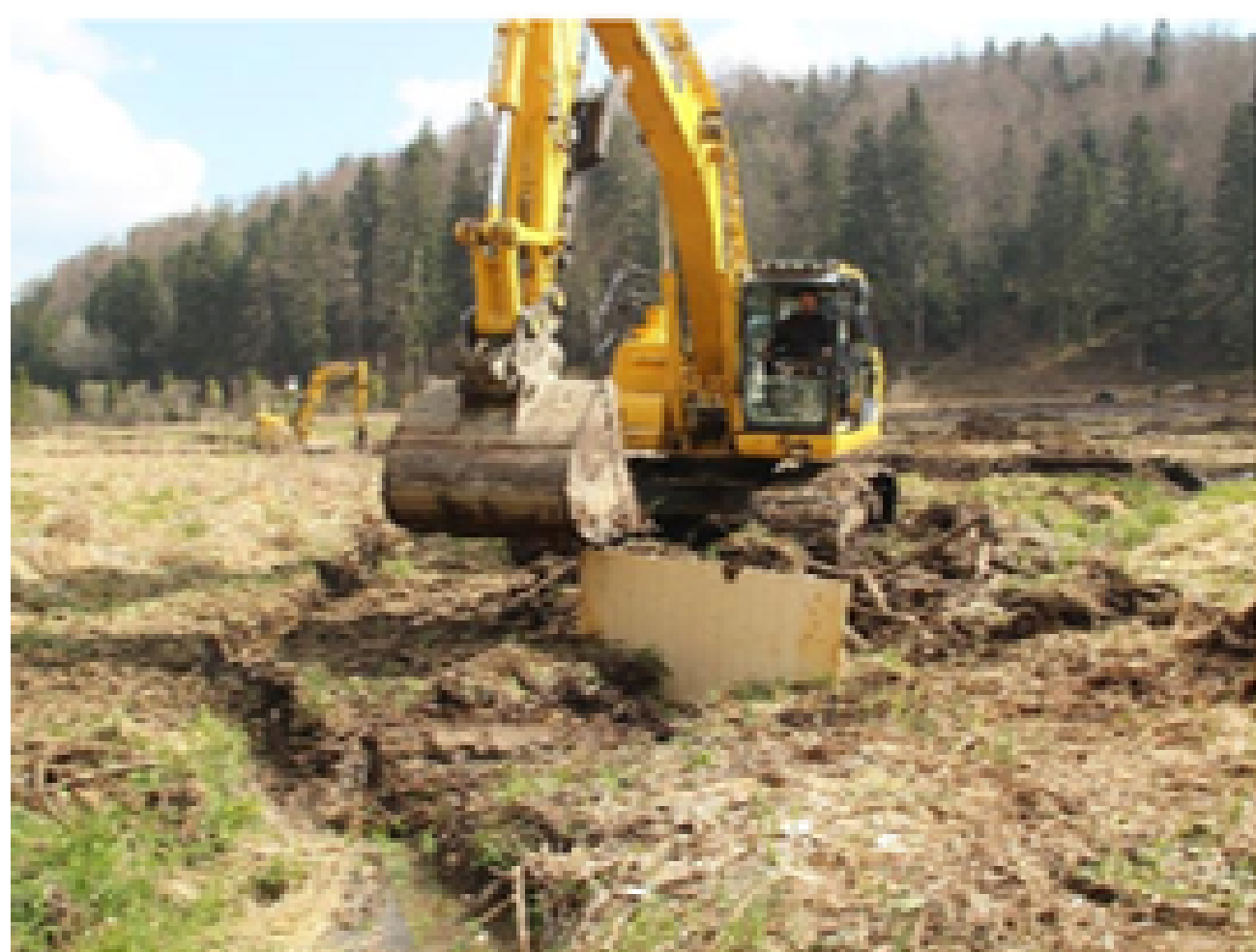
Comblement de fossés avec mise en place de panneau perpendiculaire aux écoulements (source : FDCJ)
