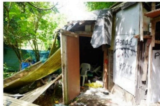
Photos avant travaux (crédit photo, ville de Montivilliers)
