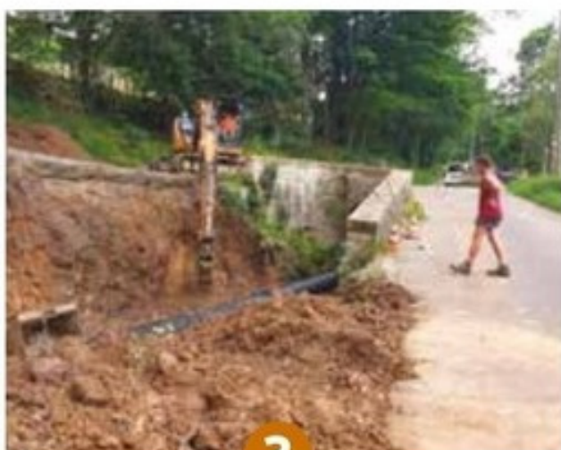
3 La berge est retalutée
