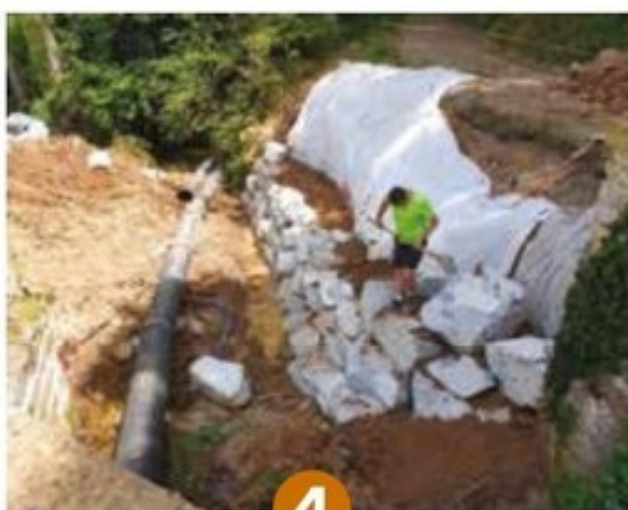
4 En pied de berge des enrochements assureront sa stabilité lors de prochaines crues
