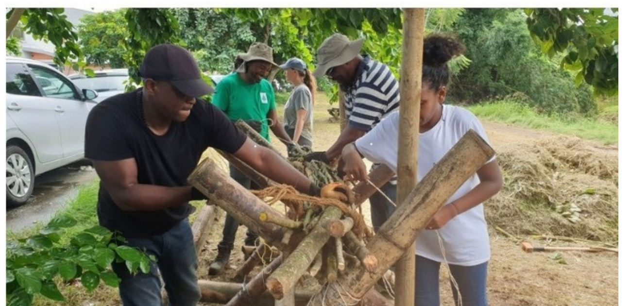
Fabrication des fascines
