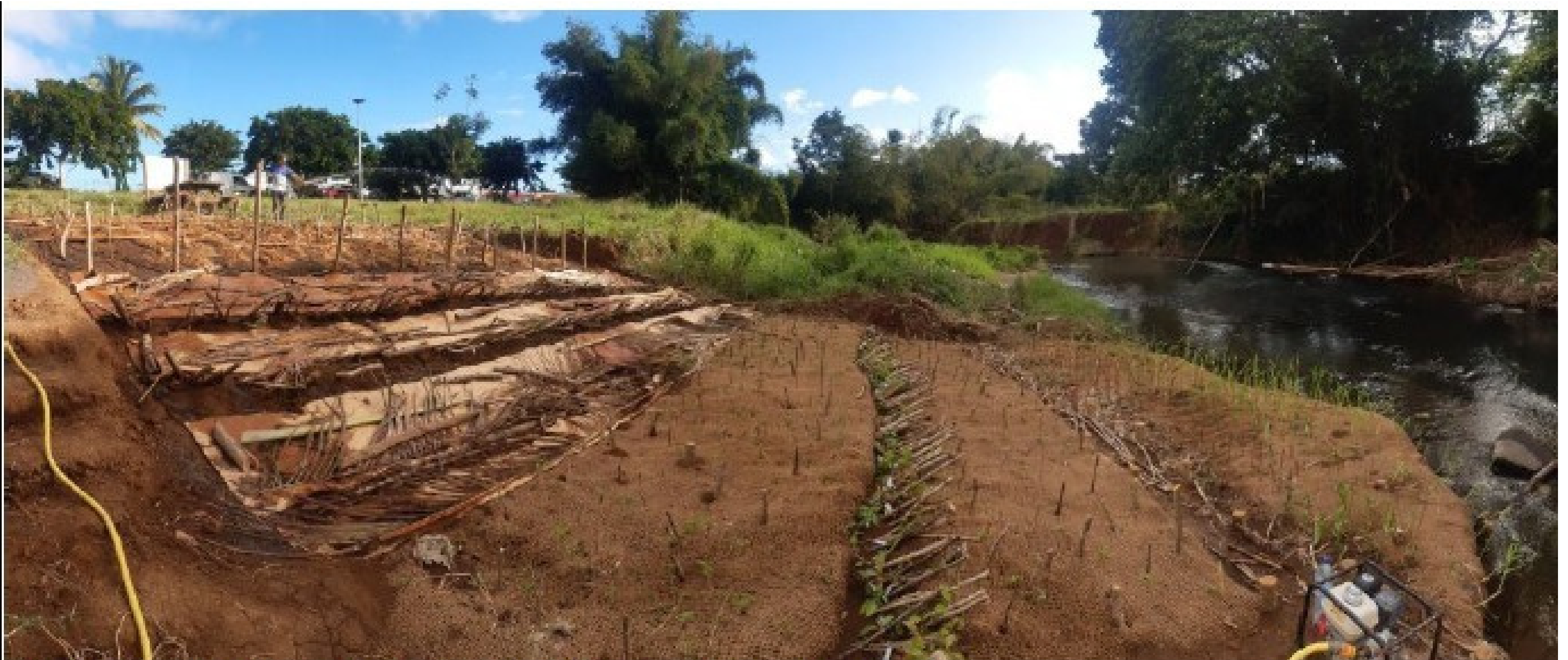
Illustration 11: Chantier-école, aménagement vue de profil
