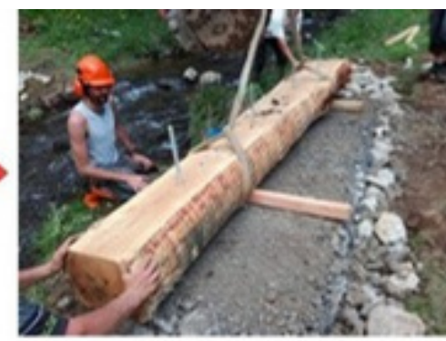
3- Mise en place des grumes
