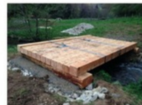
4- Mise en place du tablier
