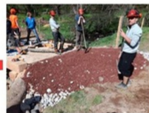
5- Mise à niveau des rampes d'accès
