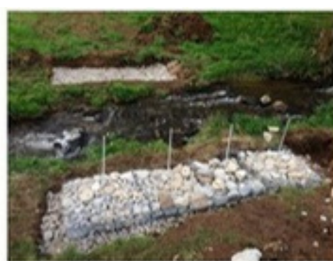
2- Mise en place des fondations (gabions)
