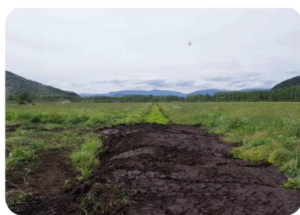
2 Drain en cours de comblement
