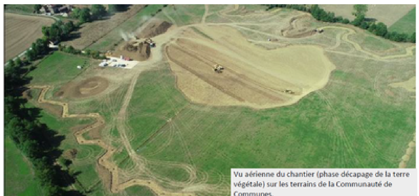
Terrassement de la platière
