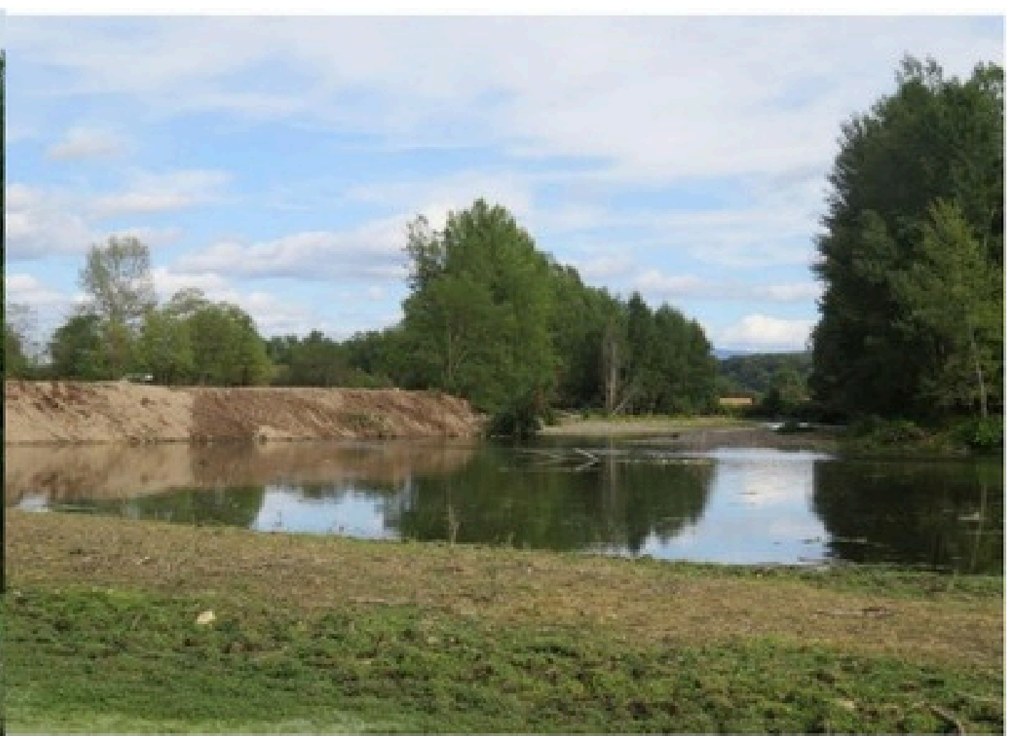
Vue de la berge juste après travaux (J.Saillard, 23/09/2019)
