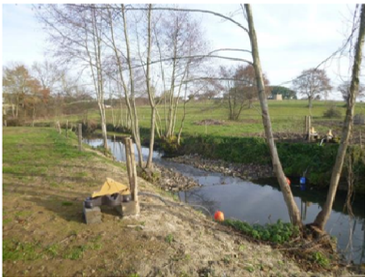
Aménagement d'une pompe d'herbage et d'un radier
