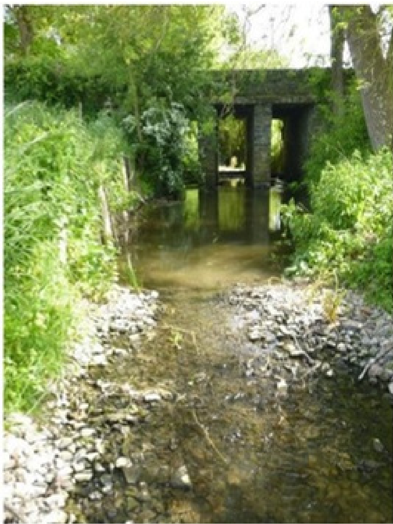
Ennoiement d'un seuil de pont
