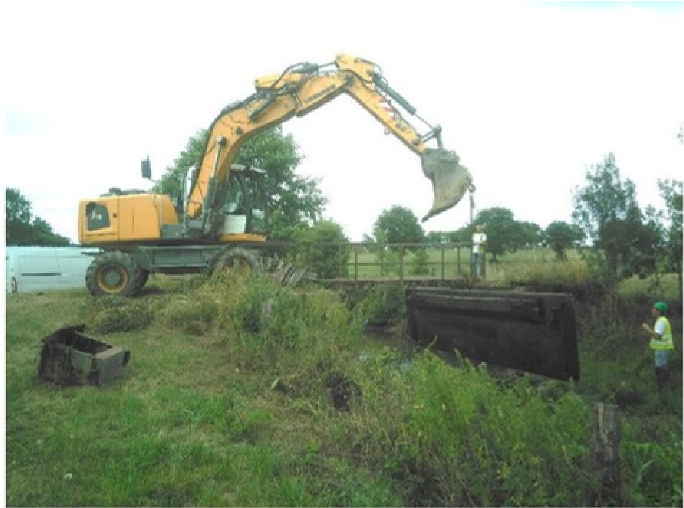
Effacement d'un clapet sur l'Homée
