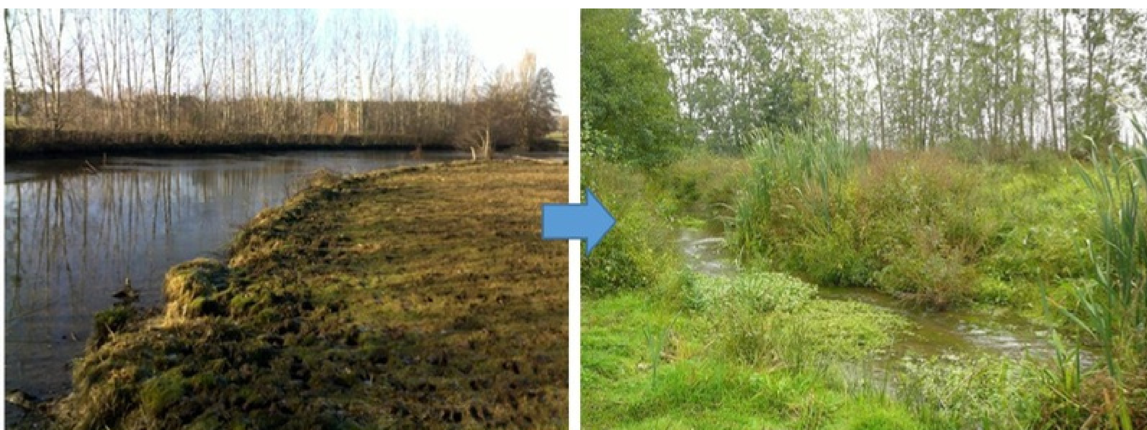
Etang du Pâtis avant et après travaux
