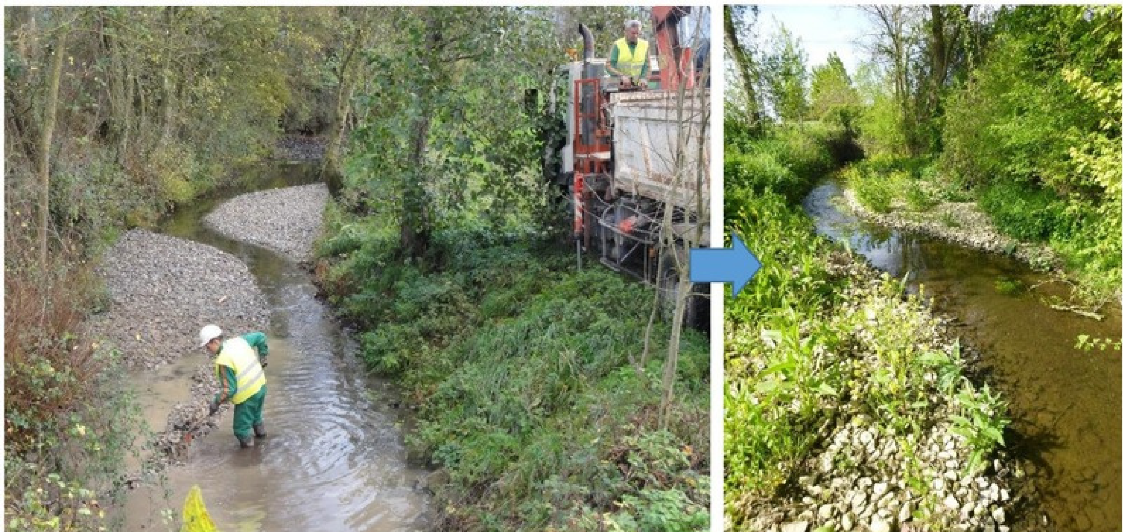
Site de Beauverger pendant et après les travaux
