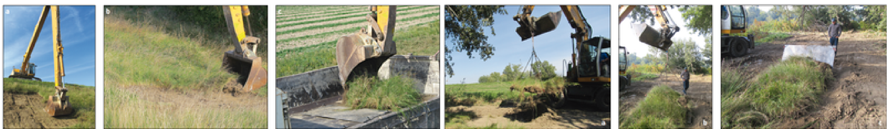
Figure 3. (a) Pelle mécanique disposée au sommet de la digue ; (b) prélèvement de la plaque de sol ; (c) dépôt des plaques de sol sur des plaques métalliques ; Figure 4. (a) Pelle mécanique récupérant une plaque métallique ; (b) dépôt au sol ; (c) glissement de la plaque de sol à terre
