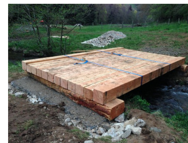
4- Mise en place du tablier
