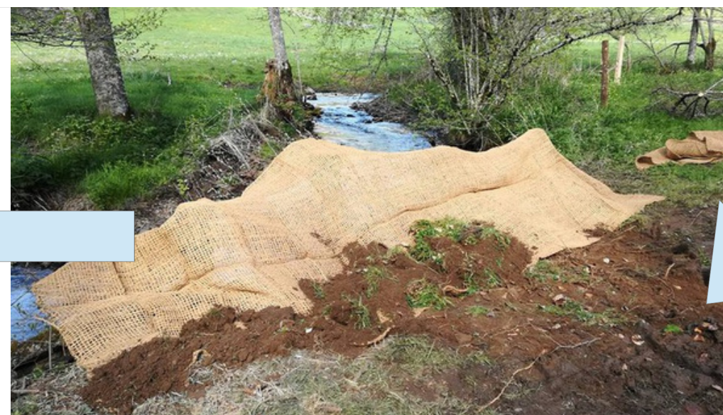
5 : Pose d'un géotextile en fibre de coco, remblai en terre et semis
