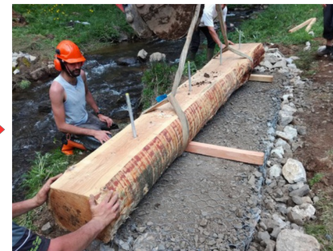
3- Mise en place des grumes douglas
