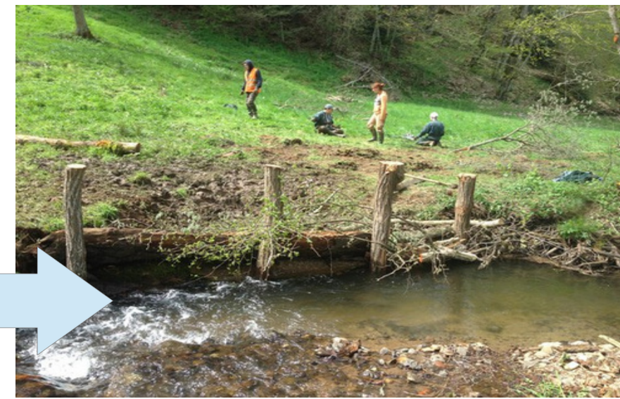
3 : Mise en place des troncs d'aulnes, remblai de terre et pierres et mise en place du lit de branches de saules
