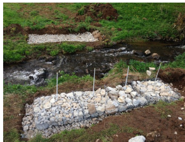
2- Mise en place des fondations (gabions)
