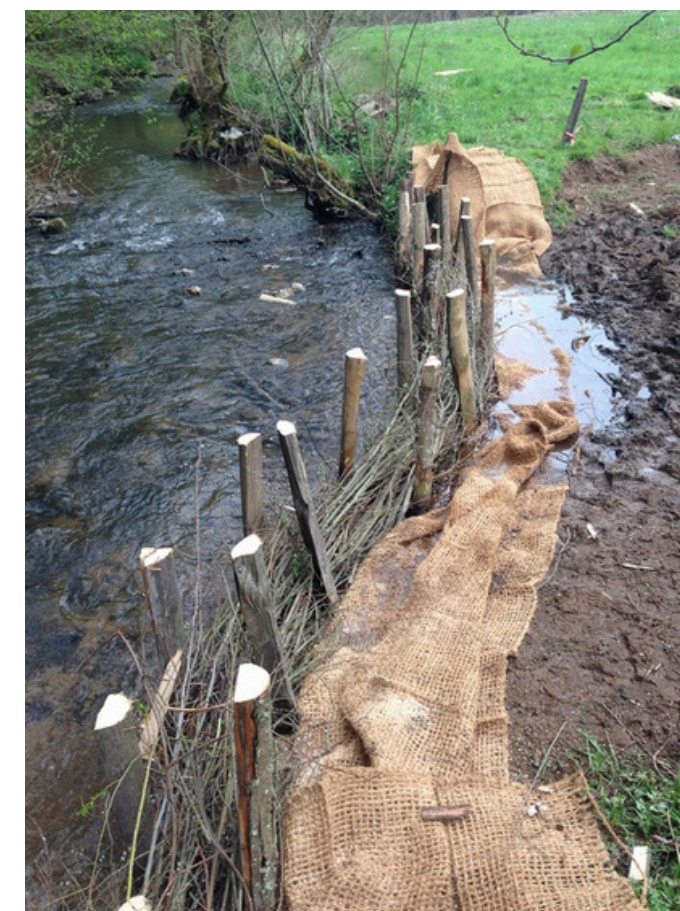
3 : Création d'un méandre, pose de la toile coco et pose des fascines de saules
