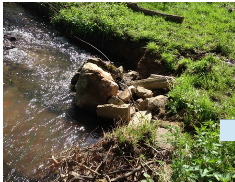
1 : Encoche d'érosion avant travaux.
