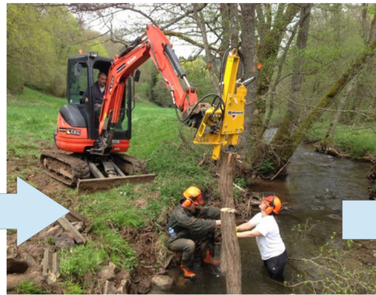
2 : Mise en place des pieux en robinier
