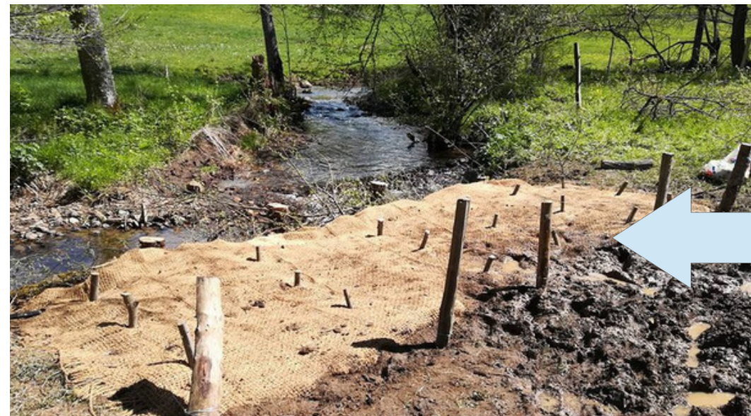
6 : Fixation de la toile à l'aide d'agrafes et de pieux vivants de saule et ligature au fil recuit
