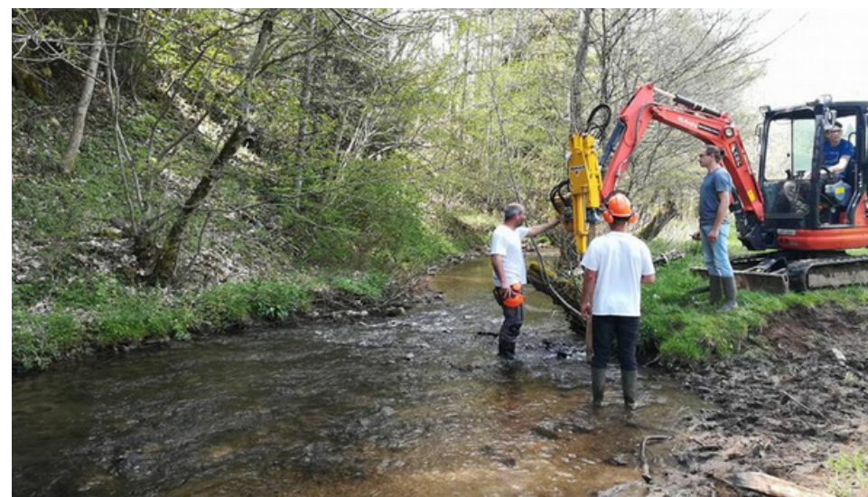
2 : Enfouissement des pieux avec la mini-pelle et l'enfonce-pieu
