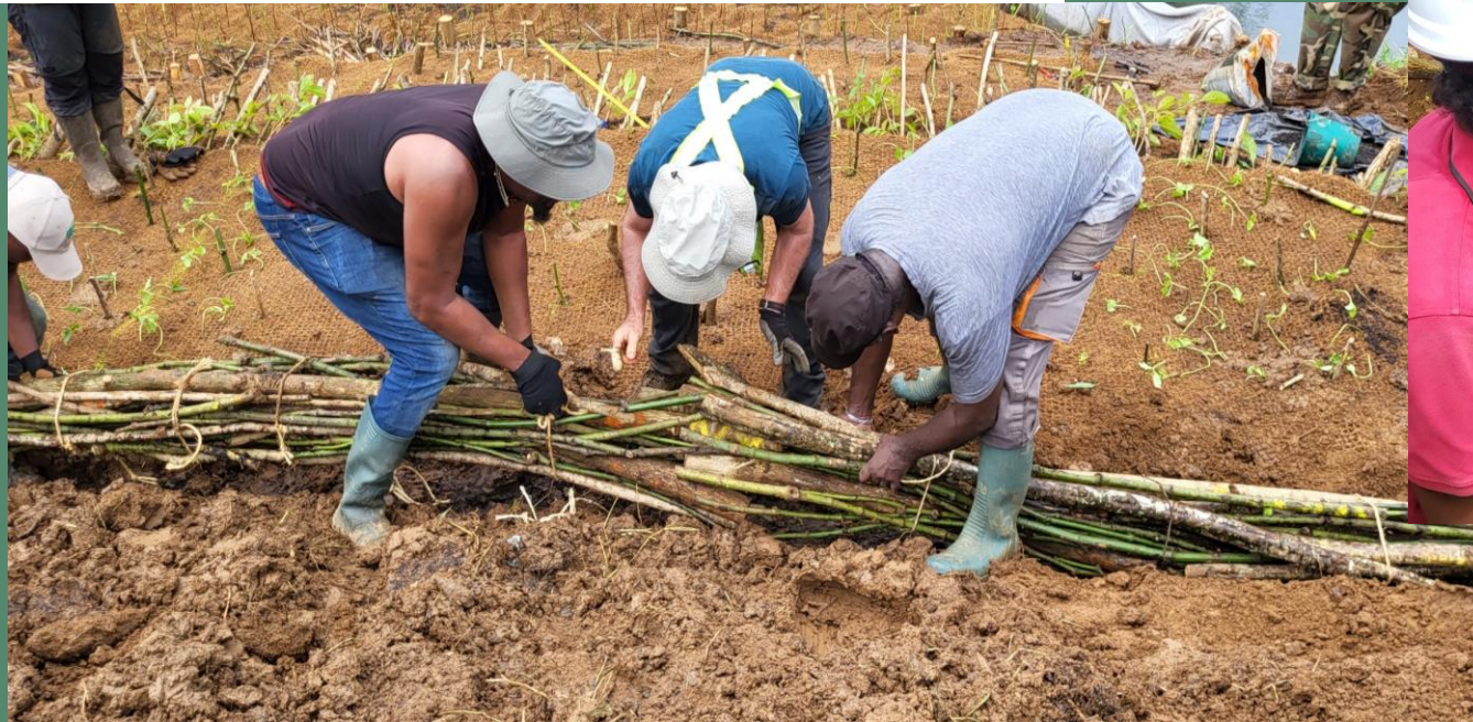
Fabrication des fascines
