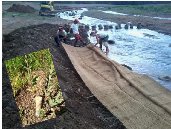
Stabilisation par techniques de génie végétal (été et automne 2017) fascines de saules (350 m) / fascines d'hélophytes (495 m) / géotextile coco (2100 ml) / couches de branches à rejets
