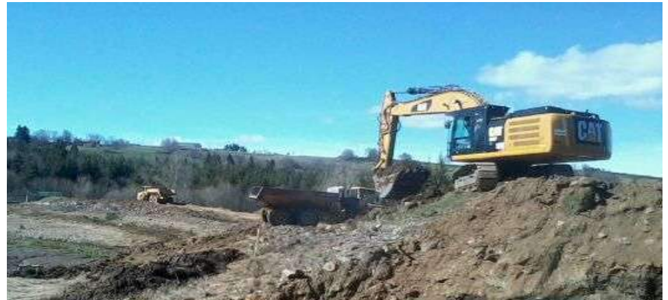
Suppression des digues et remodelage du site pour restaurer le Lignon dans son lit historique (printemps 2017)
