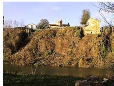
Etat de la falaise en 2008 pendant les travaux de débroussaillage et purge
